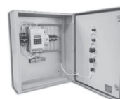
Щит (шкаф) управления типа ЩУВ, стр. 254
